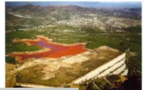
Plateforme chimique de Salindres et bassin de Ségoussac
