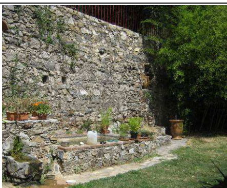
Photo 11 : Bassin (source) M.GOMES
